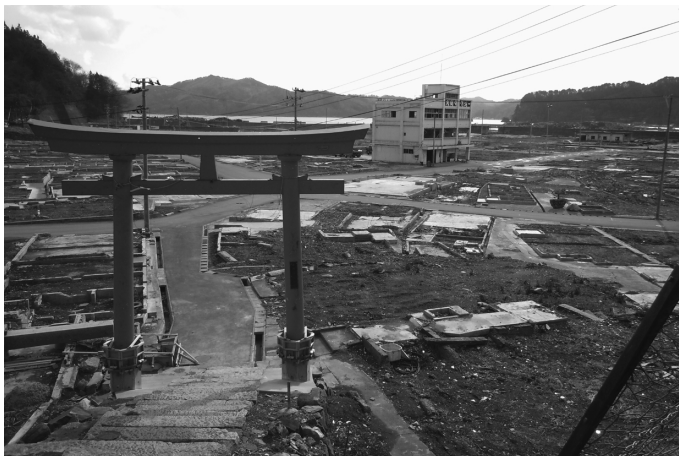
被災した安渡地区
