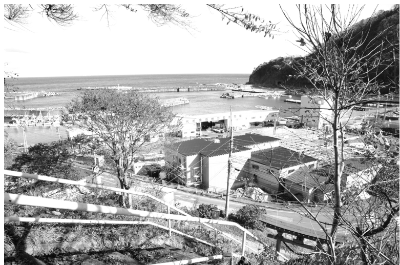
復旧工事が行われている太田名部漁港
