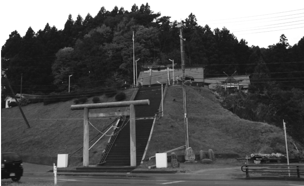
魚賀波間神社―被災した参道
