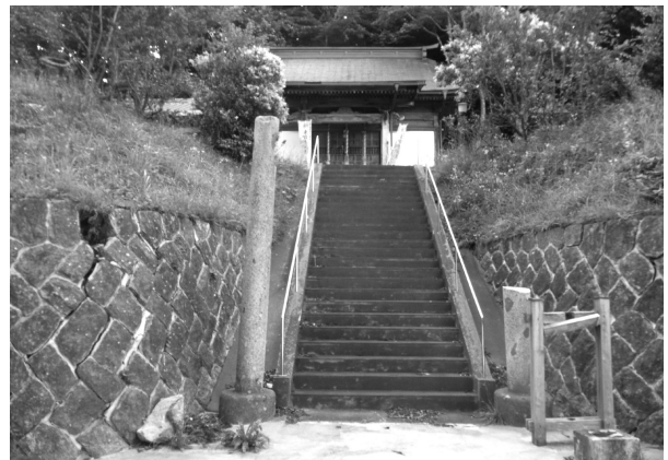
鳥居が破損した新山神社
