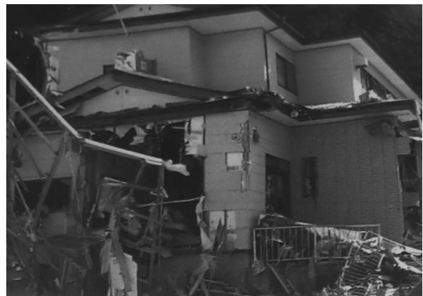
平成23年3月18日、震災直後の川原会館
