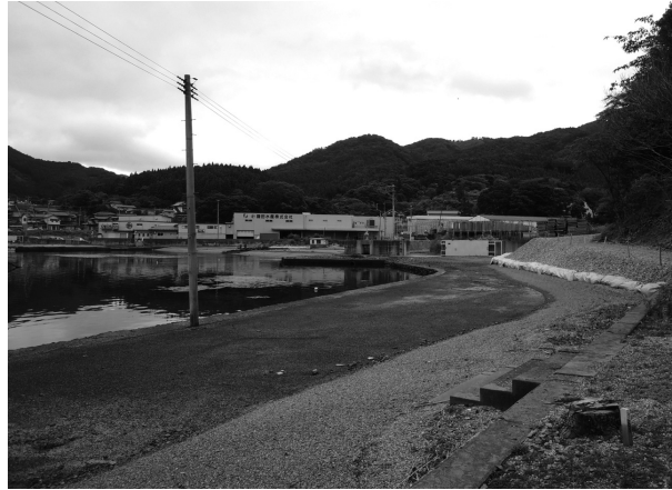
尾崎神社前の被災状況
