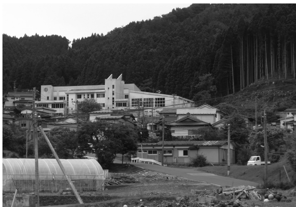
避難所に使用された旧尾崎小学校
