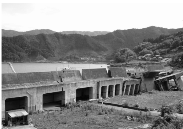
被災した小白浜地区
