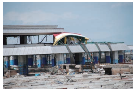
7 被災した松川浦漁港 相馬市 2011.5.2
