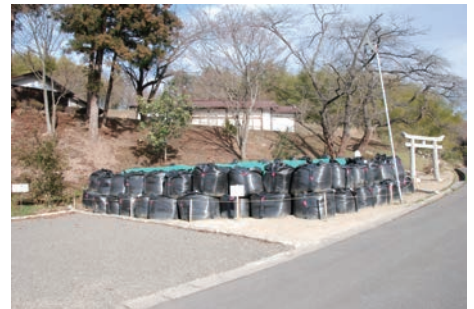
41 岡山鹿島神社の除染 福島市 2013.3.10
