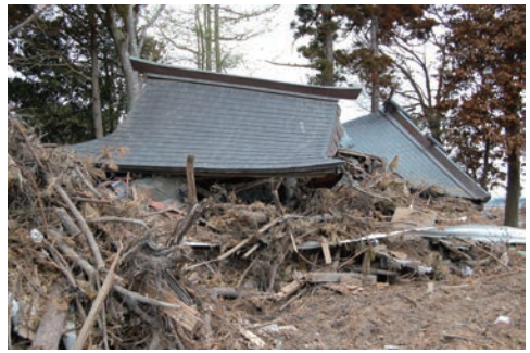
写真3 津波で押し潰された相馬市新田の大家神社 20110510
