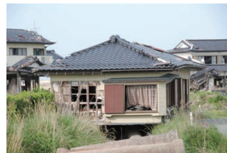
19 一階が流失し、二階部分のみ流された民家 小高区 村上 2012.5.26
