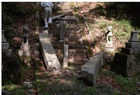
写真 2 石段上の石鳥居が倒壊し、石段の手すりをなぎ倒した。小高区蛸沢稲荷神社 110927
